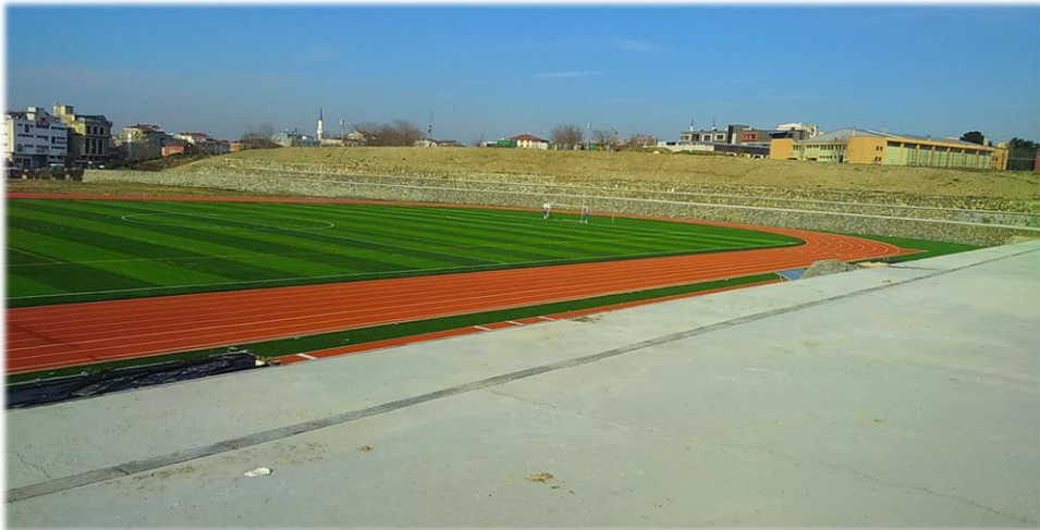
Davutpaşa Yerleşkesi Futbol Sahası sentetik (suni) çim yapılması işi
