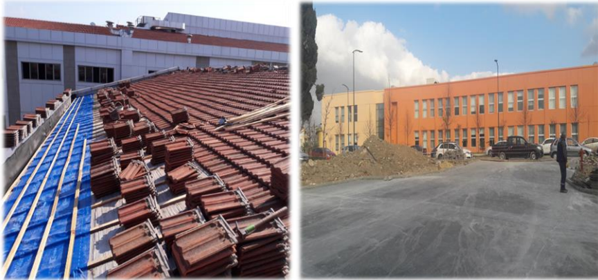
Fen-Edebiyat Fak. Atık su kanalları ve iç mahal tesisat onarımları
