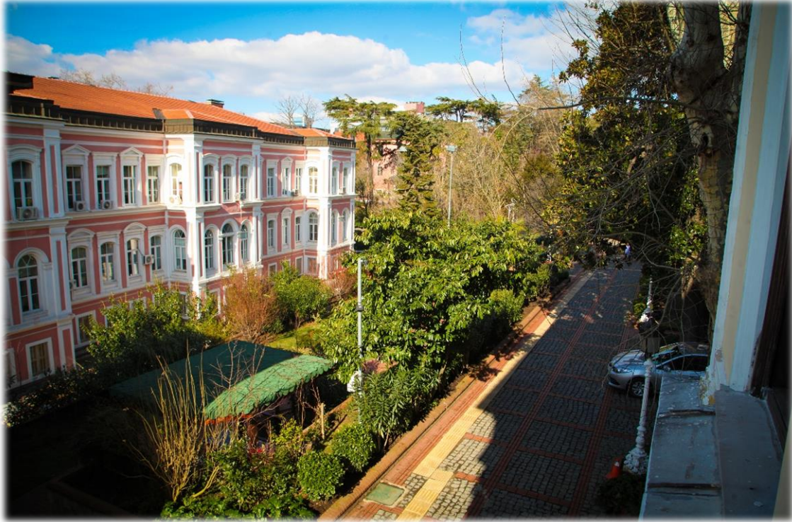
YTÜ Beşiktaş Yerleşkesi, Çukursaray Binası
