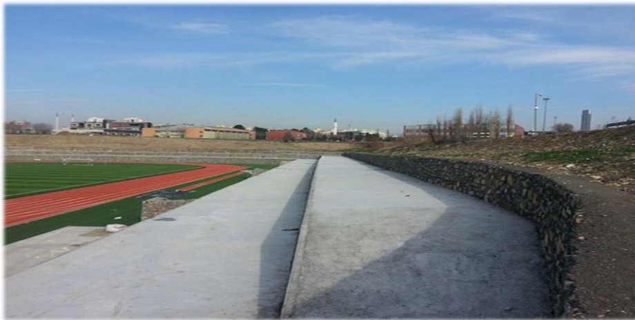
Davutpaşa Yerleşkesi Futbol Sahası çevresi teras beton ve çevre düzenleme işi.
